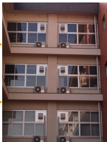
電気式空調機に更新
