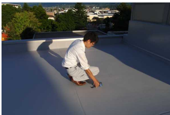
放射線治療棟新営の屋上に熱交換塗料施工_温度測定
