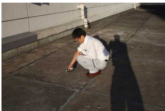
既存中央診療棟屋上(コンクリート押え)-温度測定
