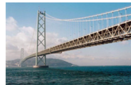
明石海峡大橋
