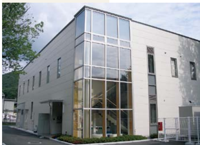
図1. ライフサイエンス実験施設 昨年6月に完成し、今年4月から本格的に稼働し始めた世界でも有数のバイオテクノロジー実験が可能な施設です。
